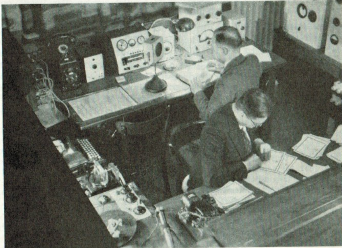
Die Arbeitsplätze auf der Leitstation des DASD in Berlin - Dahlem, aufgenommen während des Reichsbetriebsdienstes im Jahre 1935. Vorne OM Georg Zumpe, D 4 LKM, und hinten am Hauptarbeitsplatz OM Wendelin Fischer, D 4 SLD, beide während vieler Jahre freiwillig innerhalb des BD als Helfer tätig
